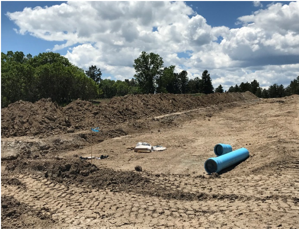
Montaine Cir Water Mains
