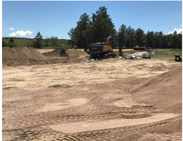
Montaine Cir Water Mains
